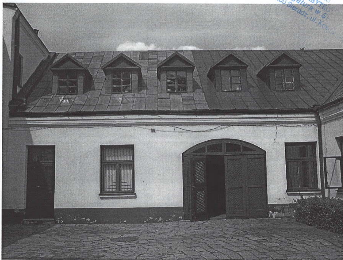
Zdj. nr2. Widok elewacji południowej.
